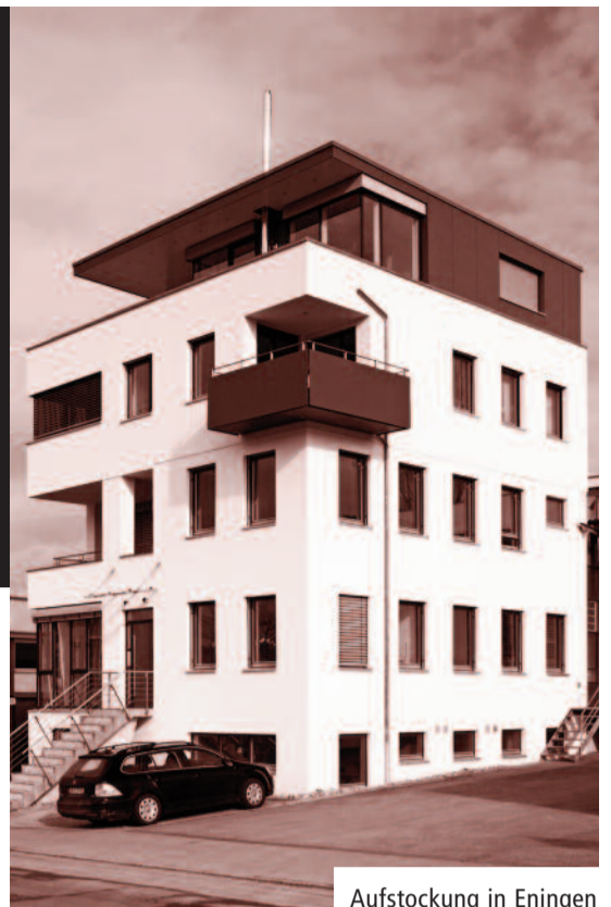
Aufstockung in Eningen
